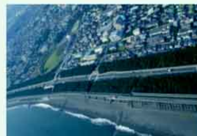
湘南海岸の沿岸防災環境保全林
