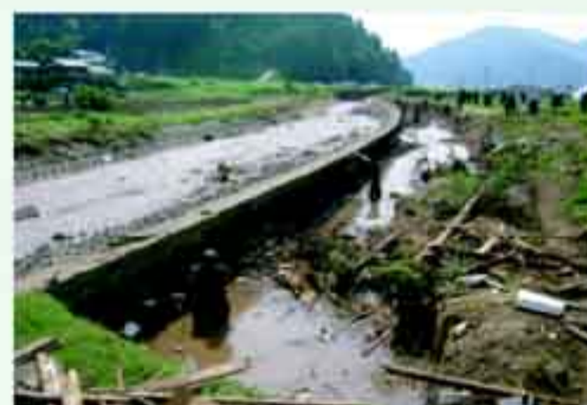
2004年福井豪雨の爪跡、越流によって堤防が浸食され消失
